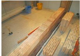
Construction du mur en béton de chanvre
