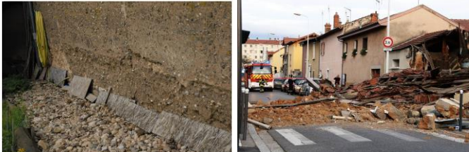
Maison d'hôte à Dolomieu (Isère)
