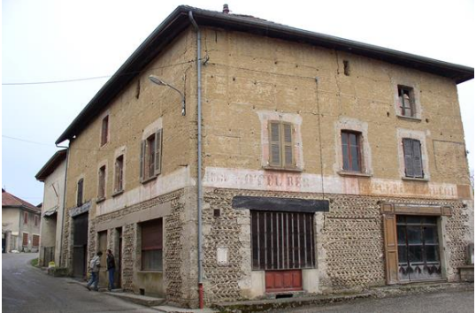
Maison en terre crue (Isère) http://www.terramata.fr/site/Architecture.html
