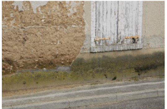
Maison à Chatanay (Isère)
