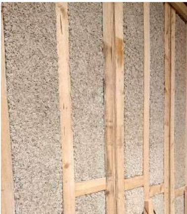
(a) Exemple de réalisation d'un mur avec ossature bois.
