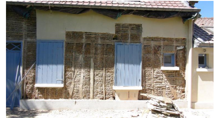
Composition de la paroi de l'extérieur vers l'intérieur : Enduit ciment, Torchis, laine de verre et Placo
