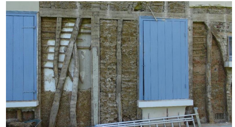
Composition de la paroi de l'extérieur vers l'intérieur : Enduit ciment, Torchis, laine de verre et Placo
