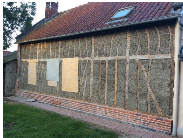
Façade extérieure : après rénovation (+4 semaines)
