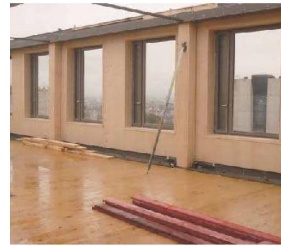
*Pluie en phase chantier sur ouvrage CLT*
