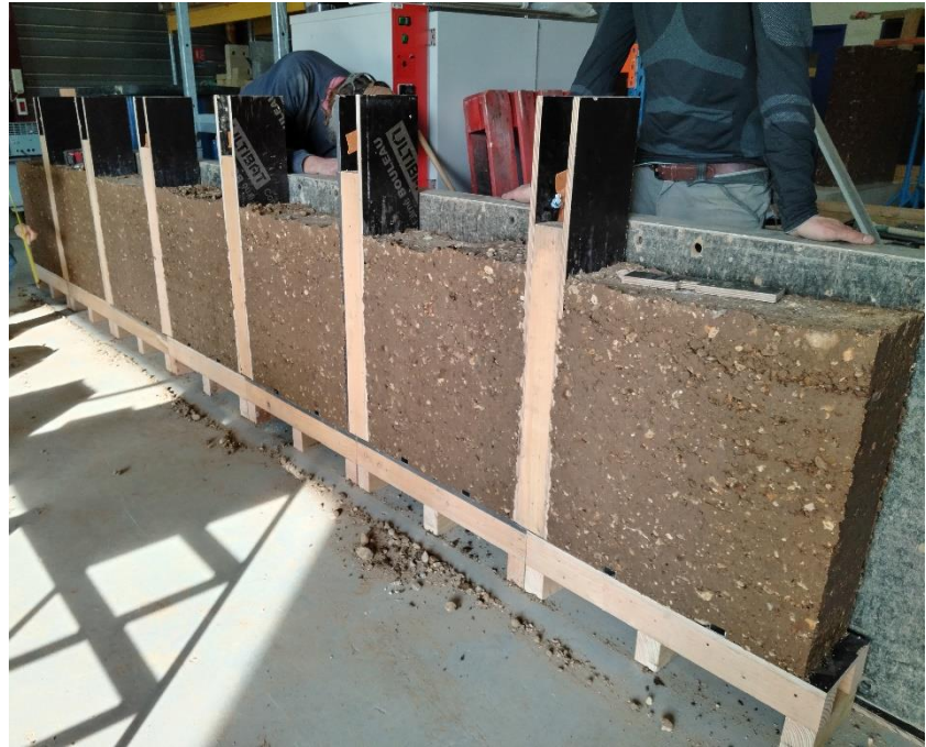
Murets en pisé réalisés pour les futurs essais
