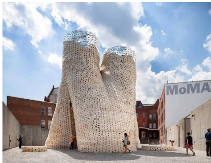
Utilisation architecturale de bio-briques de mycélium : Tour Hy-Fi au MoMA, 2014
