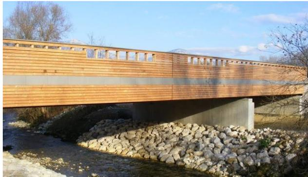
Pont de Cognin en Douglas LC (portée = 40 m, largeur = 13 m) (*Renaudin et al. 2017*)
