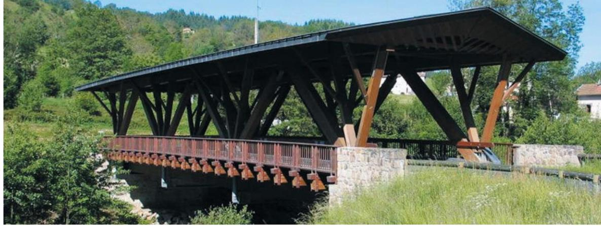
Pont routier sur la Dore à St Gervais sous Meymont (33m, structure complète en pin sylvestre et platelage en chêne)
