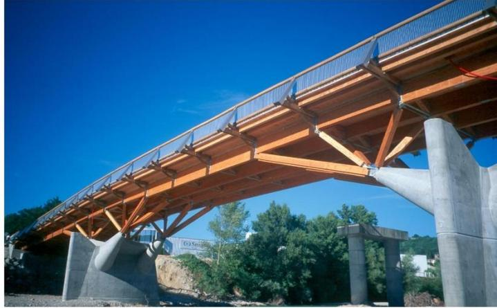
Pont routier sur la Drôme (Pont de Crest, 92m, structure complète en douglas purgé d'aubier)
