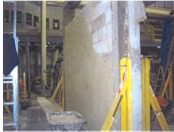
Mur bloc de béton de chanvre + enduit
