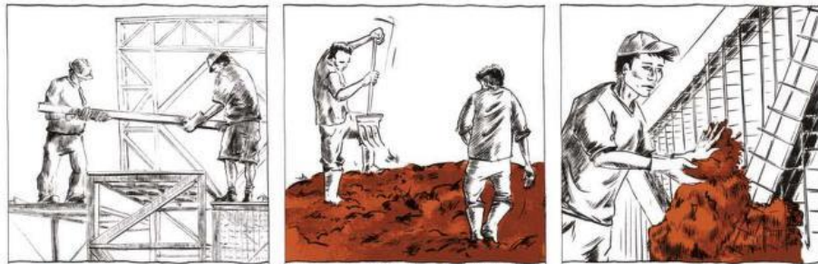
LA STRUCTURE EST MONTÉE SUR LE SITE. ELLE EST GÉNÉRALEMENT EN BOIS, MAIS ICI EN MÉTAL. LA TERRE EST MALAXÉE AVEC DE L'EAU (15 À 30 %) POUR OBTENIR UN MÉLANGE HOMOGÈNE À L'ÉTAT PLASTIQUE, AMÉLIORÉ ICI AVEC DE LA PAILLE. LE MÉLANGE EST PLAQUÉ À LA MAIN SUR LA STRUCTURE. ICI EN MAILLE D'ACIER.
