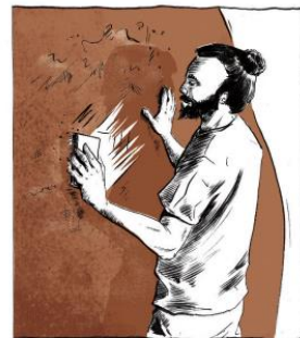
LE SUPPORT DOIT ÊTRE PRÉPARÉ AVANT L'APPLICATION DE L'ENDUIT : LE MUR EST GRATTE POUR UNE MEILLEURE ADHÉSION DU MÉLANGE, PUIS HUMIDIFIÉ.
