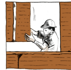
LES MODULES PRÉFABRIQUÉS SONT MIS EN PLACE AVEC UN MORTIER DE TERRE.
