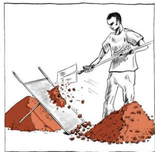
LORS DE SA PRÉPARATION, LA TERRE EST BRONÉE ET TAMISÉE POUR OBTENIR UN MATÉRIAU PULVÉRULENT, HUMIDE ET HOMOGÈNE.
