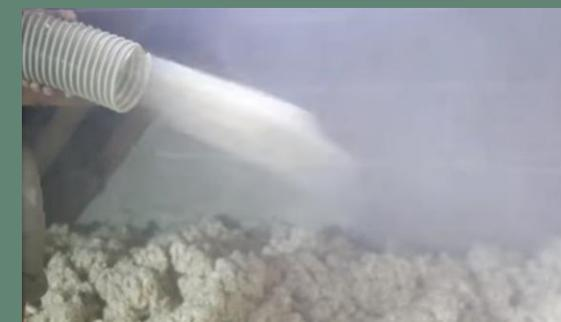
$\lambda < 0,045 \text{ W/(m.K)}$  Mva = 28 kg/m<sup>3</sup>
