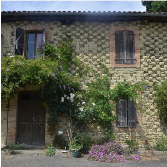
Murs de terre crue en damiers – Occitanie
