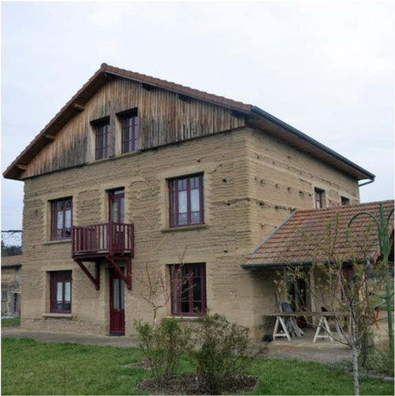
Construction en pisé – Plaine de la Limagne Crédit Photo : Université Gustave Eiffel
