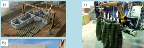
Fig. 1. Impression 3D à base de béton a) Vue d'esprit Contour crafting - b) Bâtiment Xtreee - c) Projet Matrice - Béton de l'IMT Lille Douai
