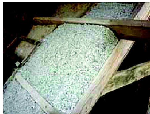
Fig. 1 : utilisation du béton de chanvre pour l'isolation des toitures
